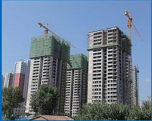
▲ 北京丽泽金融商务区A02定向安置房项目
