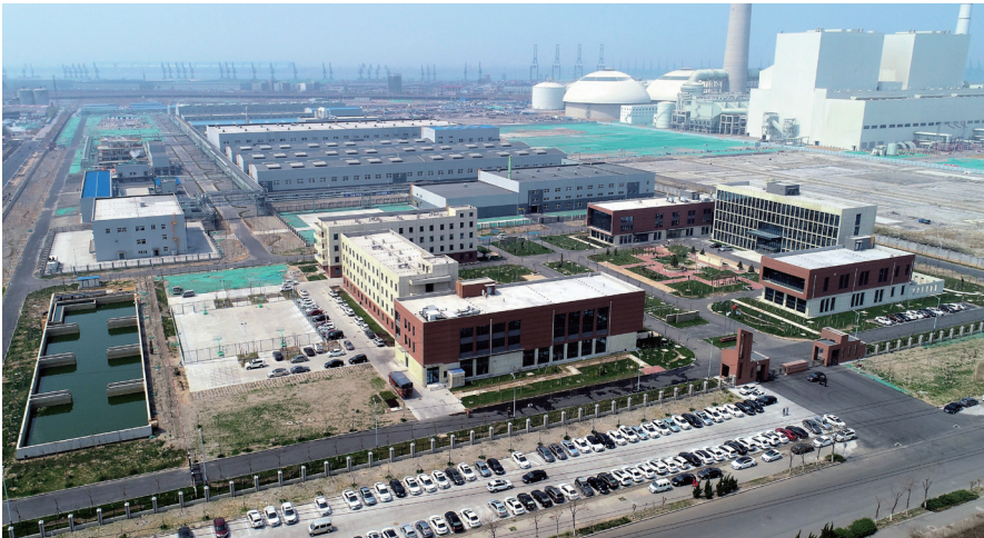
▲ 中冶瑞木新能源科技有限公司新材料项目
