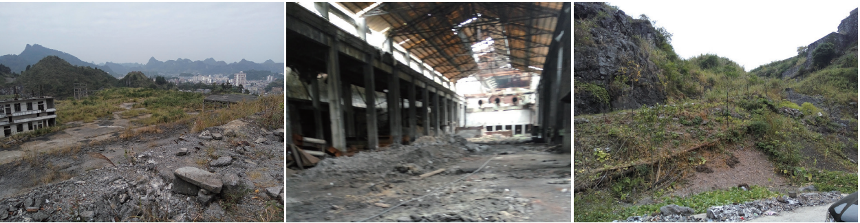
▲ 广西南丹县龙泉矿冶总厂铅锡冶炼厂、锡冶炼厂旧址场地治理修复项目
