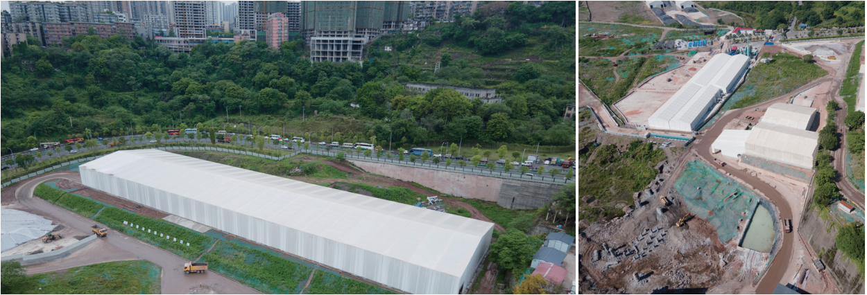
▲ 重庆钢铁炼铁厂原址场地污染土壤治理修复项目设计及施工总承包（EPC）
