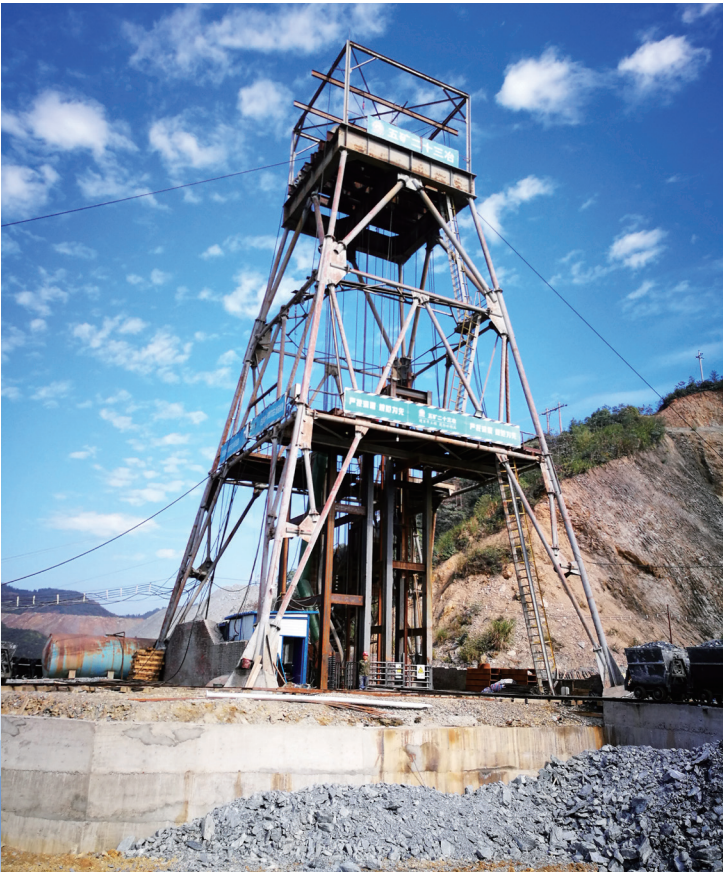
◀ 江西铜业集团银山矿业有限责任公司深部挖潜扩产技术改造项目
