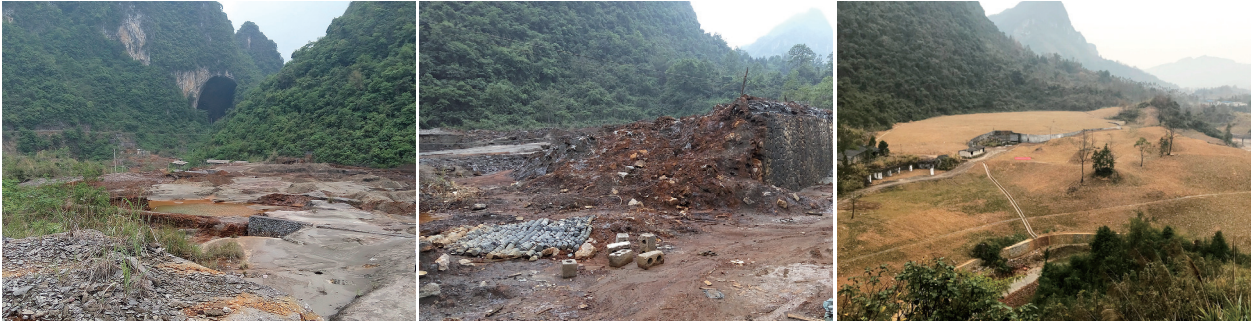
▲ 广西环江毛南族自治县才秀河道沉积尾砂治理二期工程
