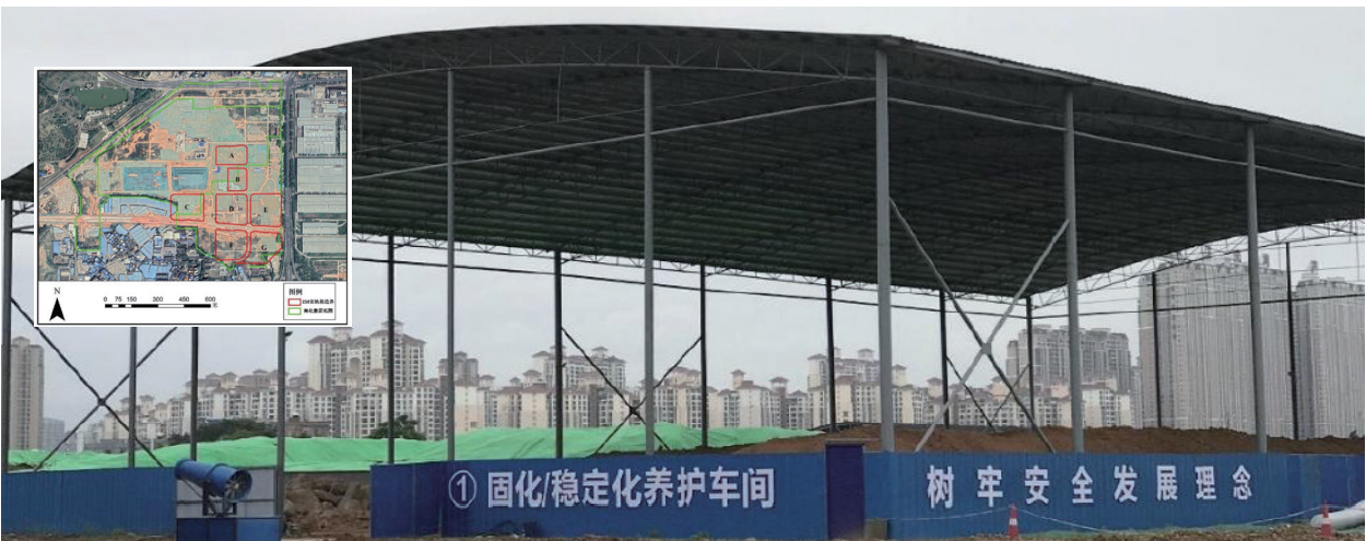
▲ 广西南宁江南中心项目土壤污染治理设计及施工工程
