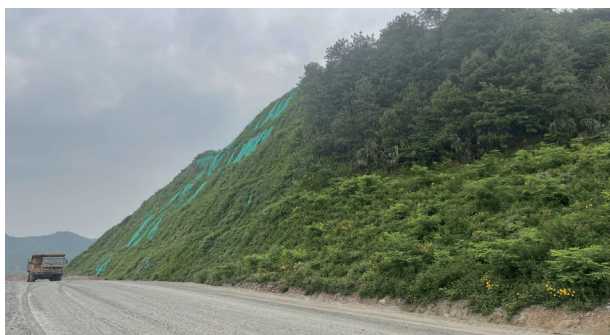
▲ 江西铜业银山矿业露采采区及排土场生态治理工程（二标段）
