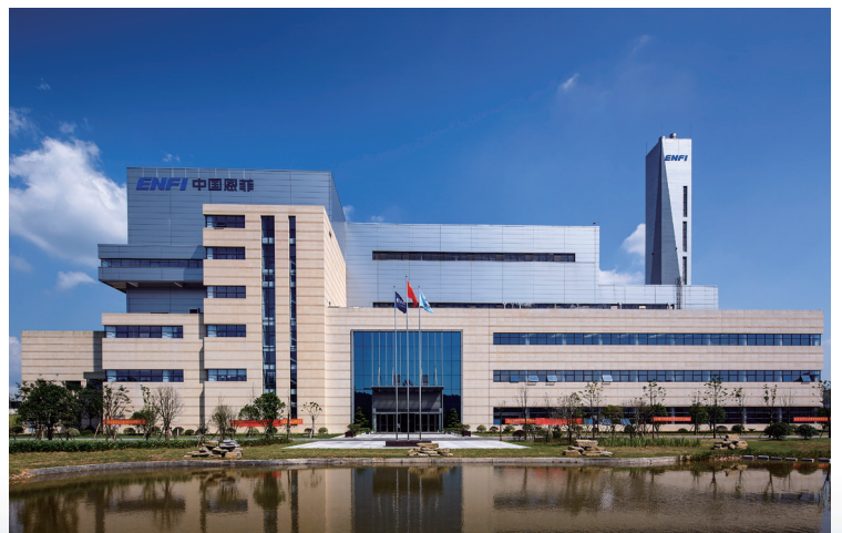
▲ 赣州市生活垃圾焚烧发电厂二期项目环境影响评价
